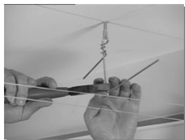
Dobre os arames de suspensão na altura do cabo-guia
