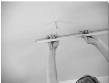
Instale primeiro o perfil T principal
